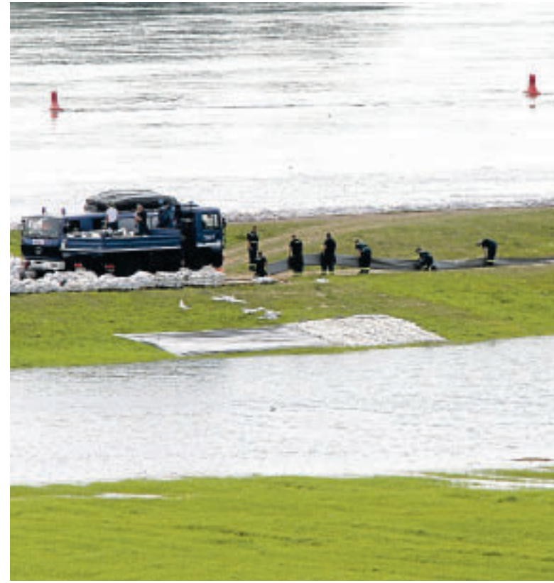
THW-Helfer verbauten bei Dömitz (Mecklenburg-Vorpommern) zusätzliche Schutzmaßnahmen gegen das Elbe-Hochwasser. Foto: Büttner/dpa
